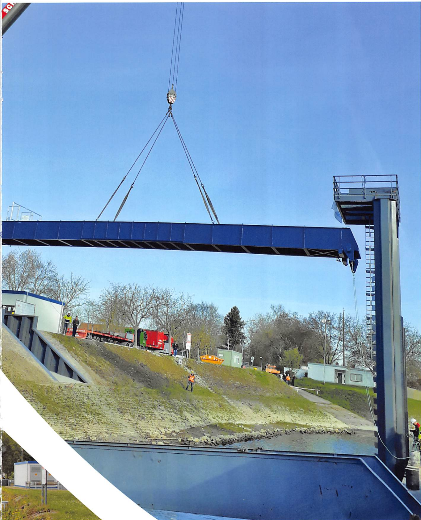
Einbau des Landgangstegs mit einem Autokran
