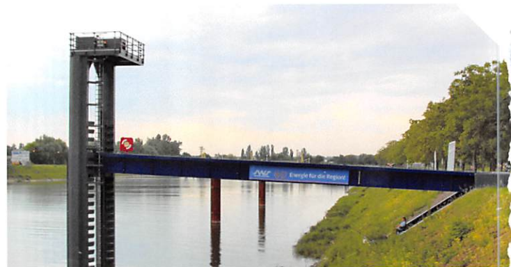
Die fertige Anlegestelle am Rheinhafen Speyer
