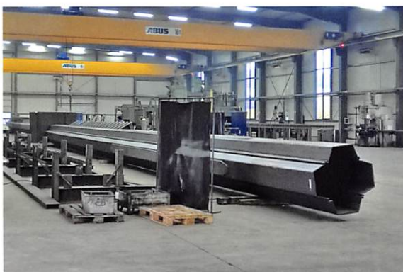
Herstellung der Brückenjochdalben
