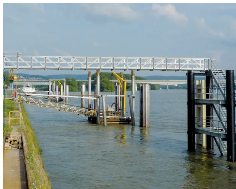
Landgangstege und Treppenanlagen am Tanklager
