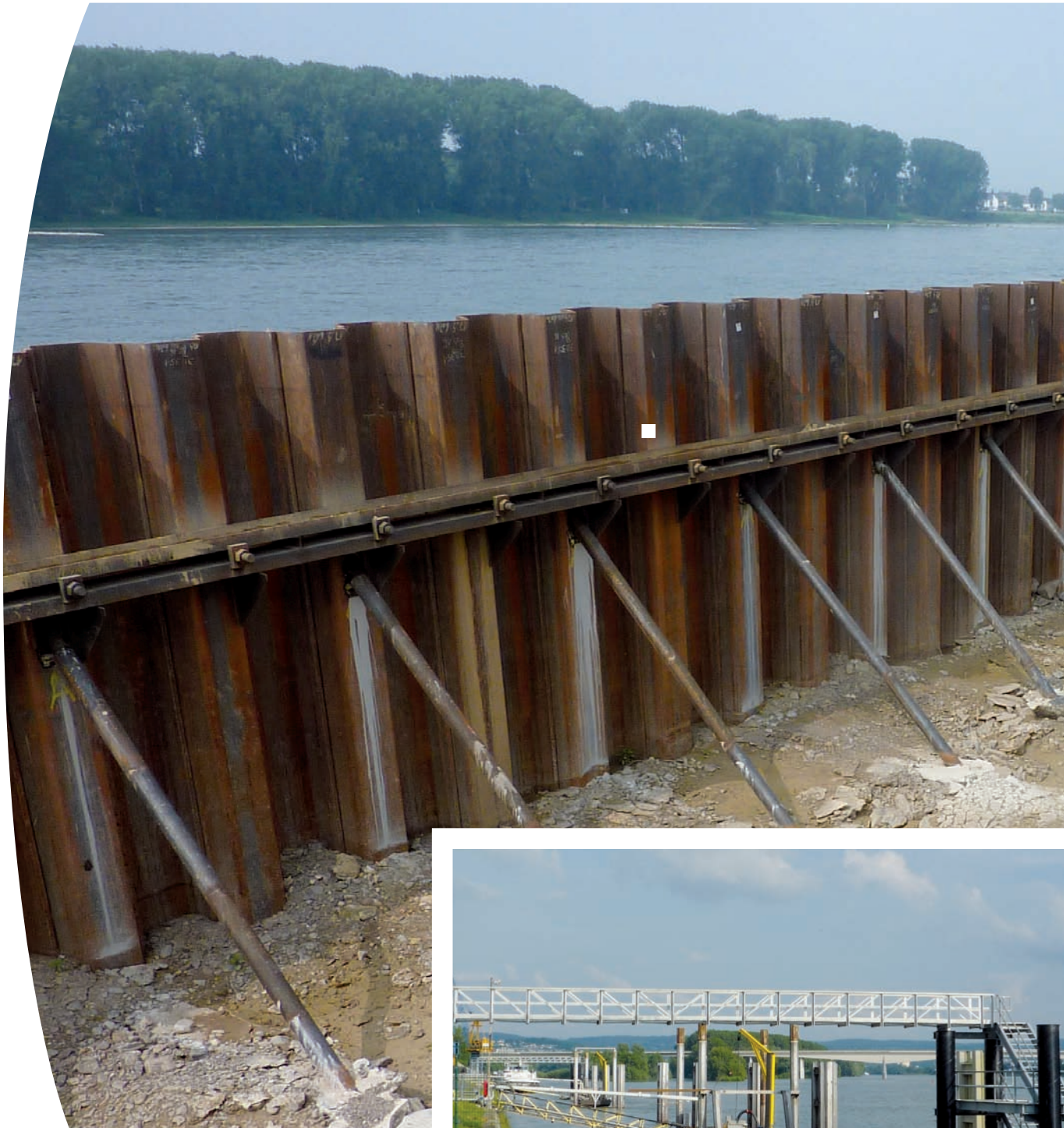
Anker mit Schutzrohr im Bereich der Hinterfüllung 2.BA
