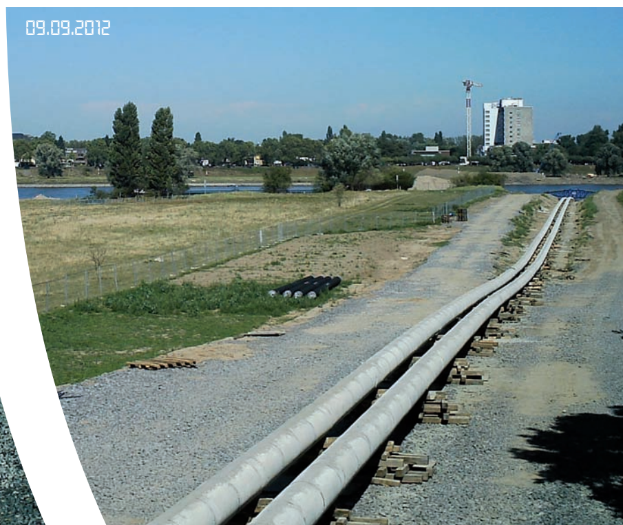
Herstellung des Dükers auf der Montagebahn
